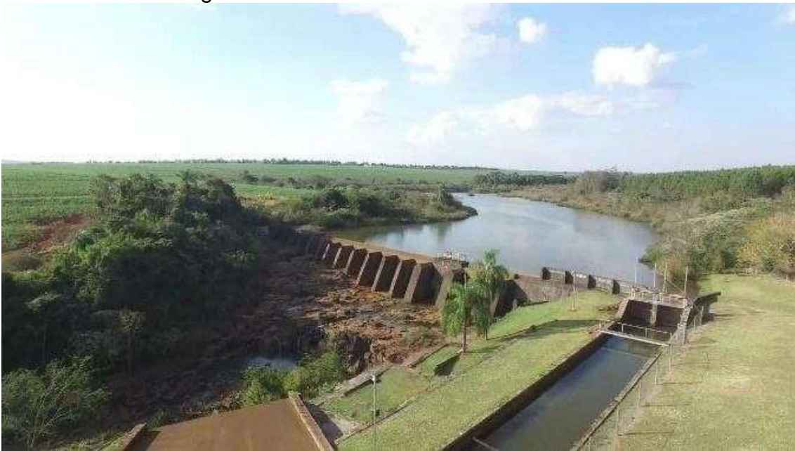
Figura 14 - Usina Hidrelétrica Salto do Lobo
