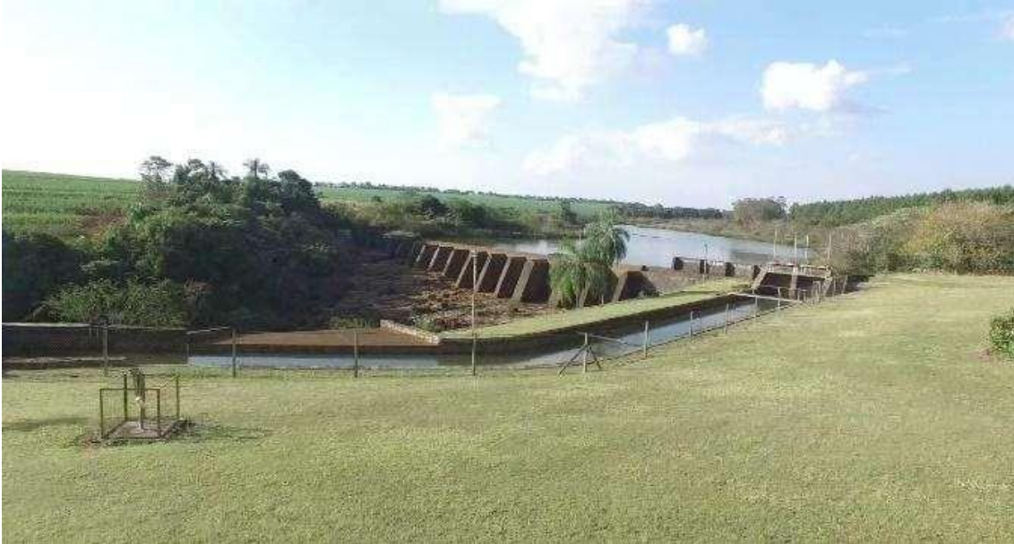
Figura 13 - Usina Hidrelétrica Salto do Lobo
